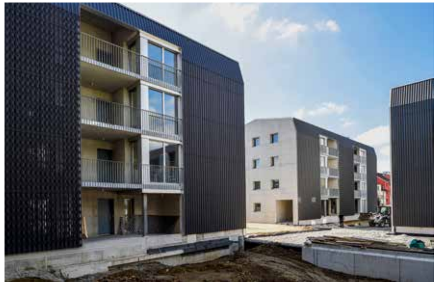
Die Erschliessung der Wohnungen erfolgt über Laubengänge.
