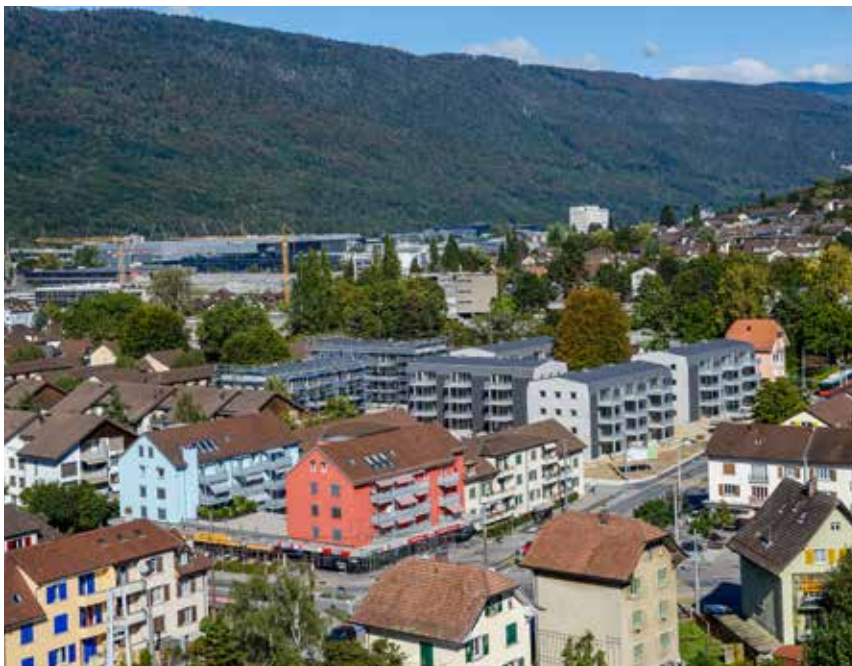
Der Wohnpark Les Amis liegt im Bieler Quartier Mett. Die sechs Häuser der ersten Etappe sind weitgehend fertiggestellt, bei der zweiten Etappe (links von den Neubauten) wird es 2018 soweit sein.
