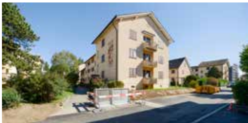
Altbauten, die in der zweiten Etappe ersetzt werden.
