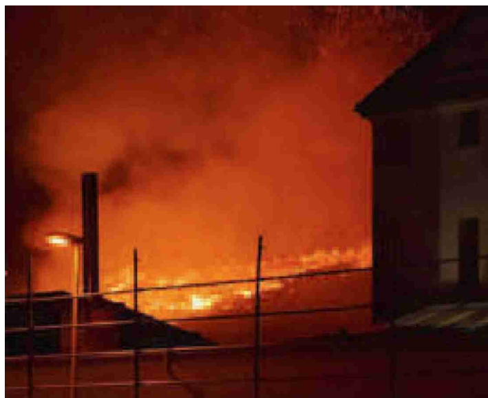
Der Brand an der Solothurnstrasse 1 hat das frisch renovierte, ehemalige Drahtzuggebäude stark beschädigt. Leserbild/anonym
